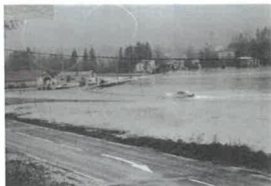
Cette cartographie montre que le remblai routier protège des inondations par venue d'eau depuis l'amont pour des temps de retour jusqu'à 100 ans au moins. Il convient toutefois de mettre en perspective l'étude hydraulique réalisée avec le cliché photographique : la RD est partiellement submergée laissant présager une protection pour des temps de retours inférieurs à 100 ans.
